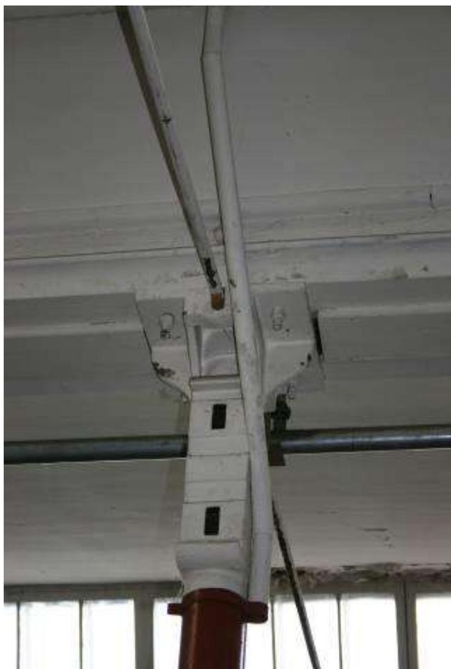
**Détail du système d'ancrage des transmissions**
