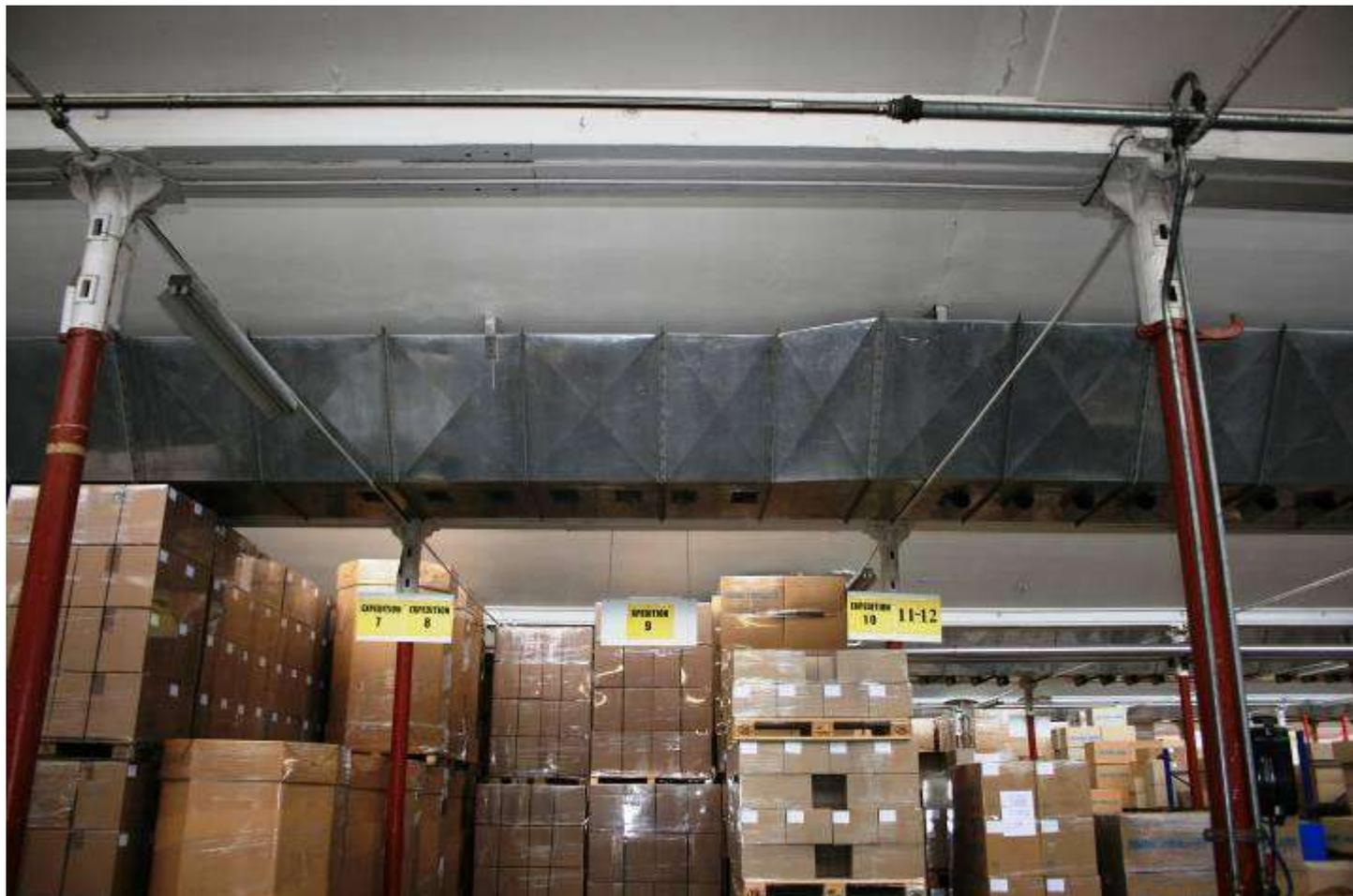
**Intérieur des sheds : poteaux en fonte, système d'ancrage des transmissions, poutres soutenant les noues**
