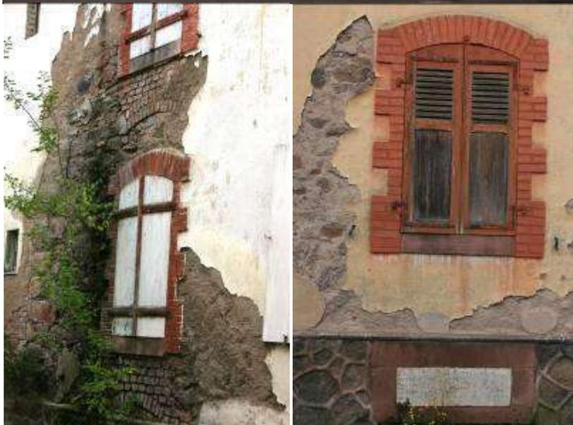
Détails de fenêtre. A gauche, mur gouttereau côté rivière ; remarquer les arcs de décharge. A droite, mur gouttereau sud-ouest, côté cour de l'usine ; la construction est de moellons. Le socle est plaqué de granite en opus polygonum.
