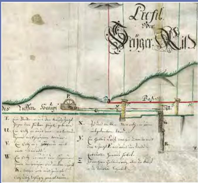
Extrait du plan des mines de Musloch (1740), montrant la transmission du mouvement de la roue hydraulique vers les pompes inférieures.
