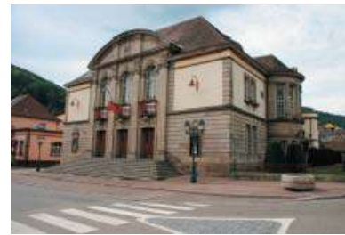
La décoration de la façade du théâtre explore le registre des arts.
