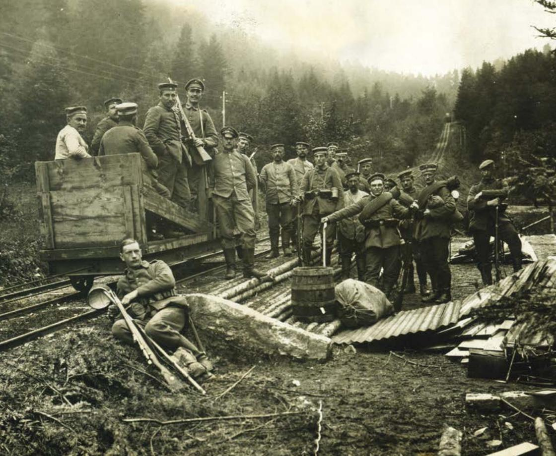
Die Standseilbahn ist ein zentrales Element dieses militärischen Transportnetzes. Sie funktioniert mit Zugseilen: während eine Lore auf einem Schienenweg nach oben fährt, fährt eine andere auf einem zweiten Schienenweg als Gegengewicht nach unten.
