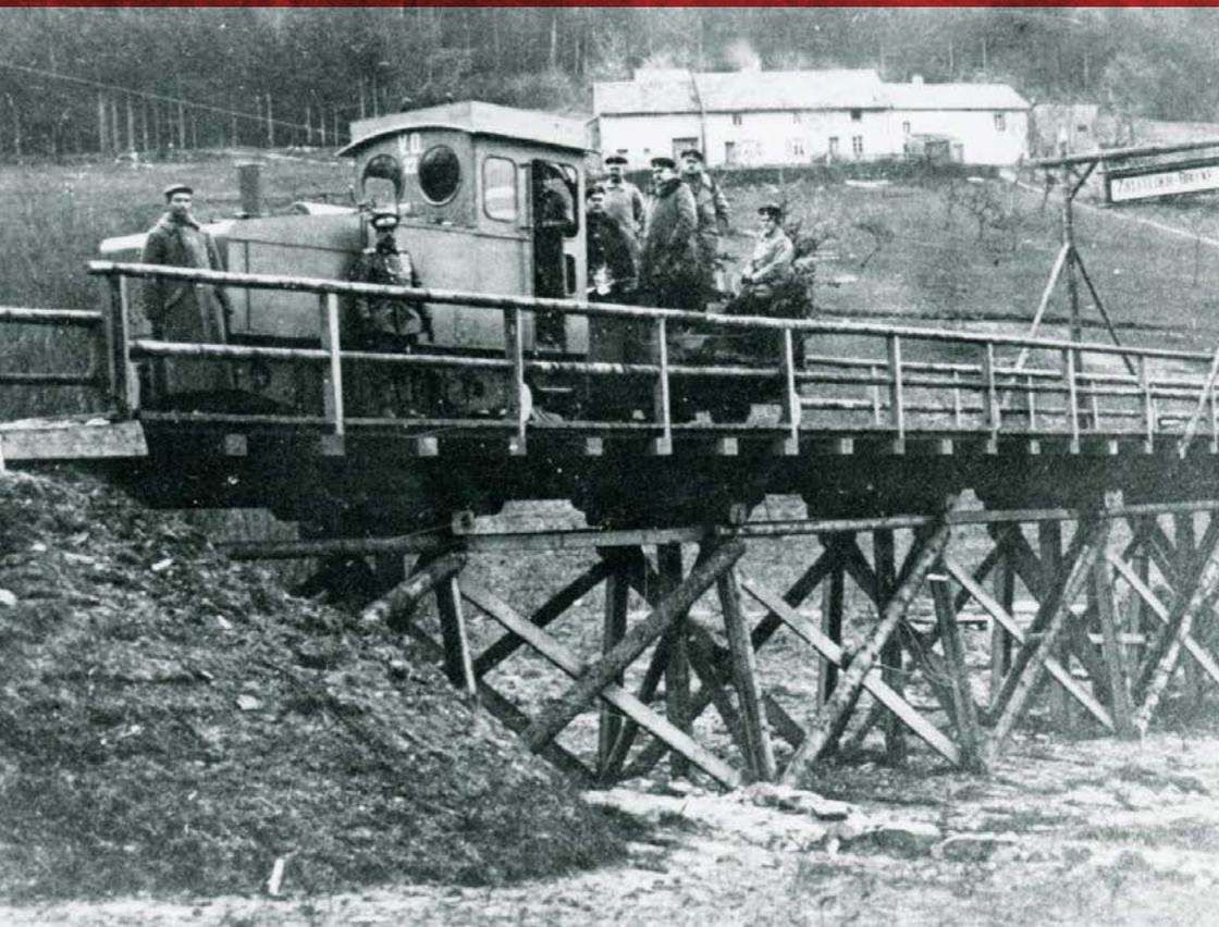
**S**chmalspurbahnen gehören zu dem deutschen Transportsystem und werden durch Standseilbahnen und Seilbahnen ergänzt, die Menschen und Material an die Front bringen. Sie bestehen entweder aus Schienen ohne Schwellen oder aus Schienen mit Holz- oder Metallschwellen.
