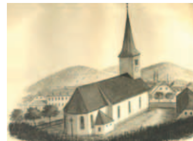
Église de la paroisse Saint Louis à Sainte-Marie-aux-Mines. État originel du bâtiment
