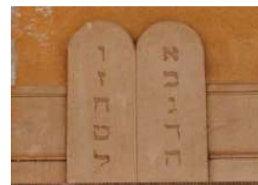
Les Tables de la Loi sont situées au-dessus de l'ancienne porte d'entrée de la synagogue. Elles se lisent de droite à gauche et représentent par un chiffre en hébreu les 10 commandements.
