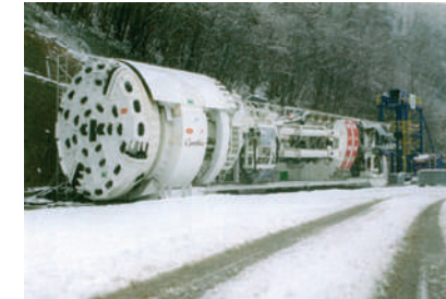
Le tunnelier Cynthia a permis de creuser une nouvelle galerie de sécurité, parallèle à l'existante.
