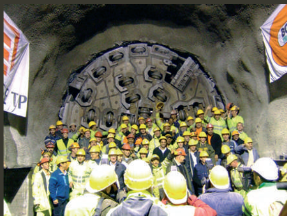
Le tunnelier Cynthia qui a percé les 7 km de galerie.
