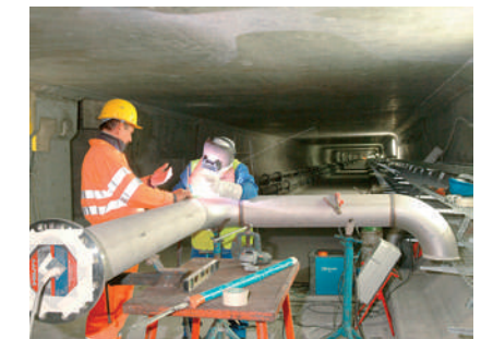
Installation de la conduite incendie dans la galerie de sécurité.
