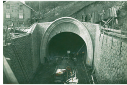
Travaux de soutènement de l'entrée du tunnel, côté Ste-Marie, en 1933-1936.
