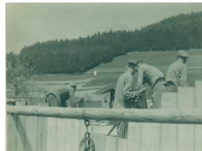
Déportés travaillant sur un chantier de Ste-Marie-aux-Mines, durant la 2 ème Guerre mondiale.
