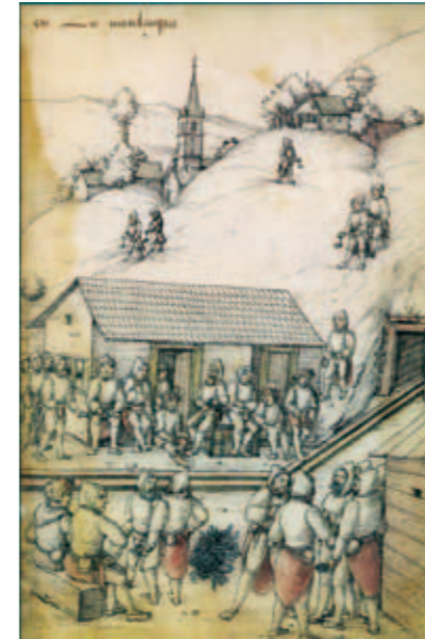
Les mineurs, équipés d'un cuir fessier, d'un marteau et d'une pointerolle, attendent d'entrer dans la mine où ils partent pour 8 heures de travail. Ouvrage d'H.Groff, 1529.
