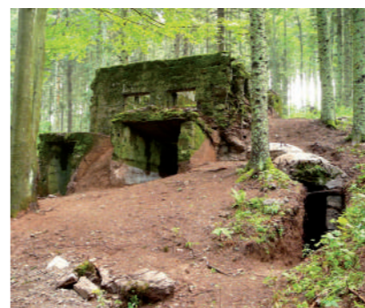
Betonturm ou poste de défense avancé en béton construit par les allemands
