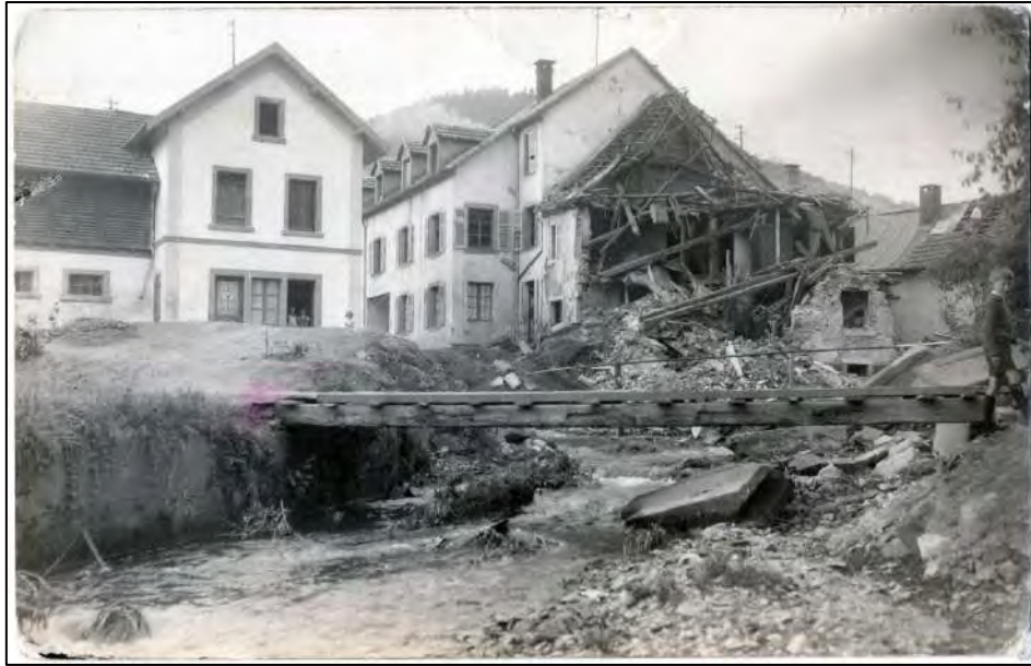
Le pont de Saint-Blaise dynamité
