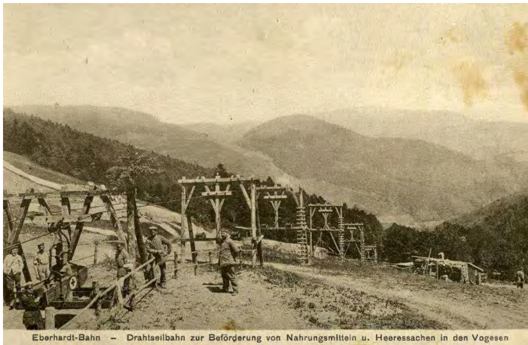
Document 18 : téléphérique militaire Eberhardtbahn desservant le vallon du Petit-Rombach jusqu'à la Chaume de Lusse (Archives municipales de Sainte-Marie-aux-Mines)
