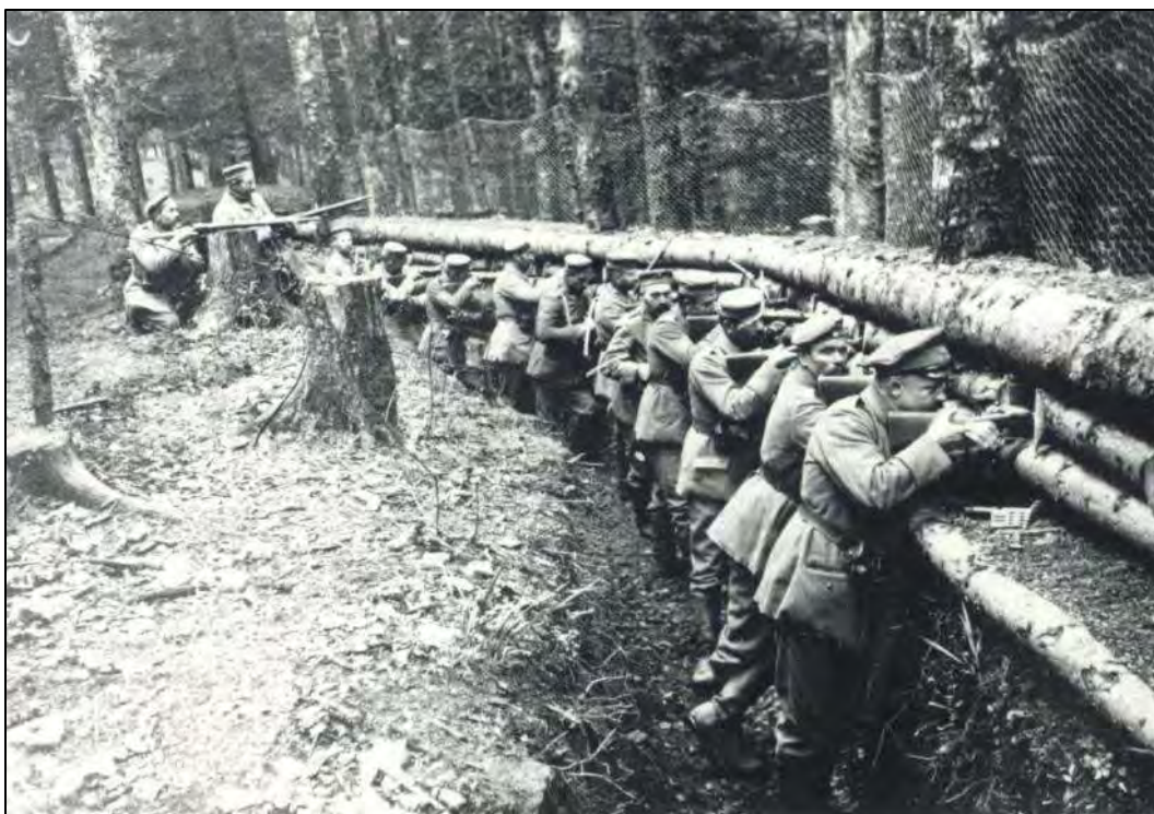
Document 16 : tranchées surélevées par des rondins de bois. Situées en première ligne du front, elles sont équipées de filets pare-grenades et de fenêtres de tirs (Coll. R. Guerre / reproduction Archives municipales de Sainte-Marie-aux-Mines)
