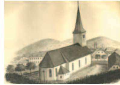
Église de la paroisse Saint Louis à Sainte-Marie-aux-Mines. État originel du bâtiment
